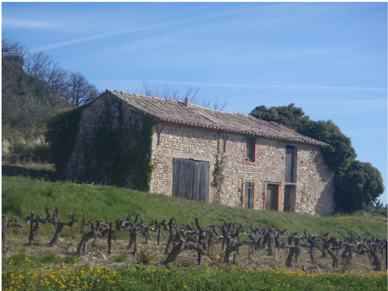
▲ Rasteau, Charavin, l'édifice à un étage est maçonné en galets. Au-dessus, dessin d'un mur en galets par Claude PERRON.
